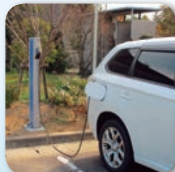
安全・安心の業界初「無接点方式」EV/PHV用ケーブル自動巻取り式充電スタンドは、現在、お取引企業様やゴルフ場などの駐車場に設置いただいております。
